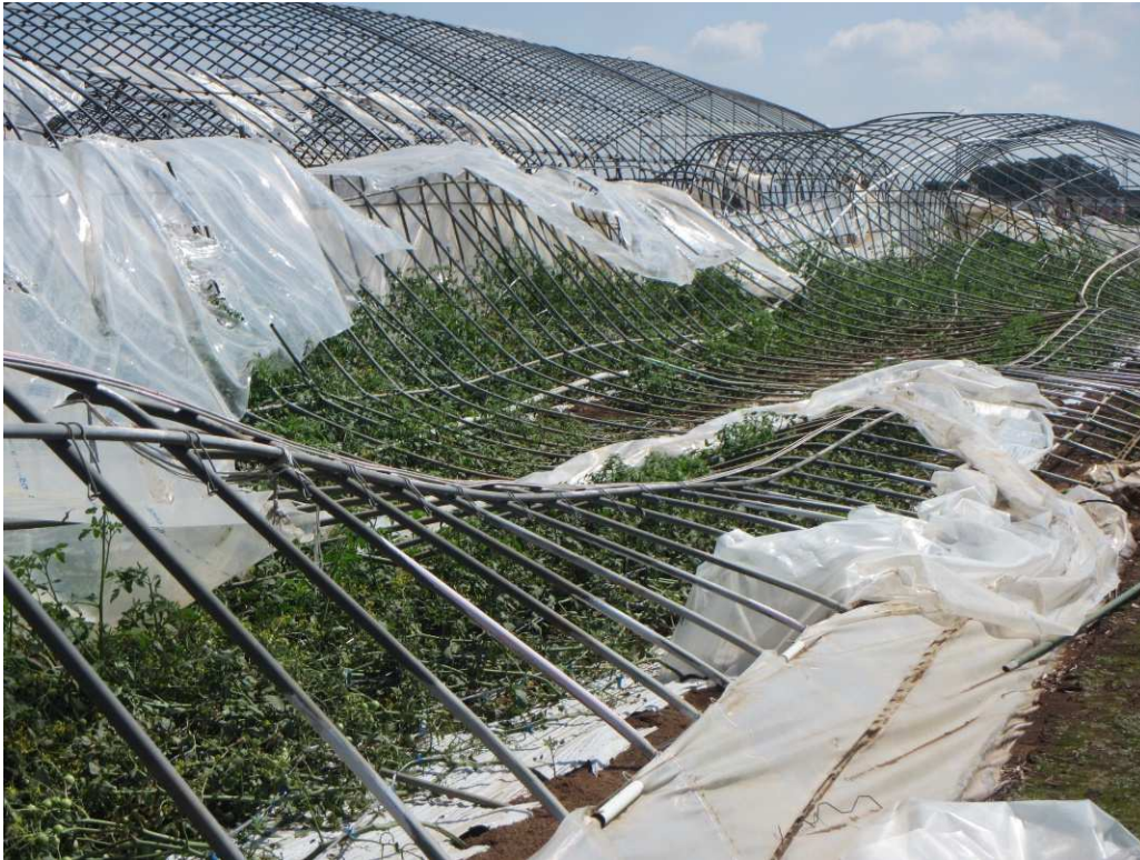
農業用ハウスの損壊
