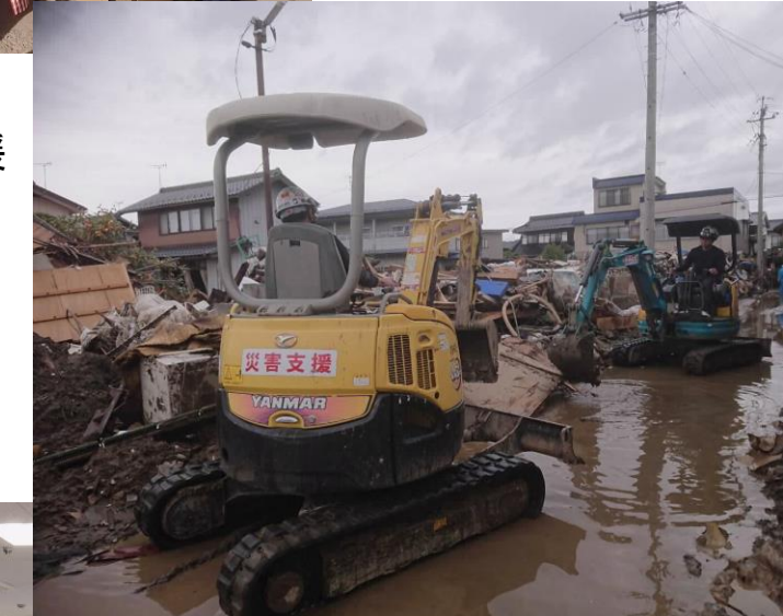
重機作業支援
