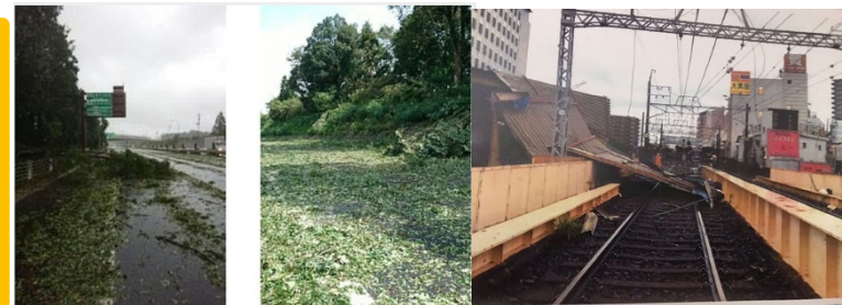
NEXCO東日本損傷状況
