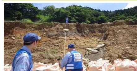
法面崩落状況調査と法面安定性の確認
