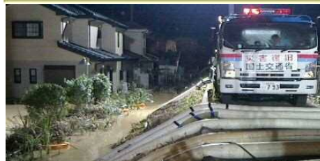
排水ポンプ車による24時間体制での緊急排水
