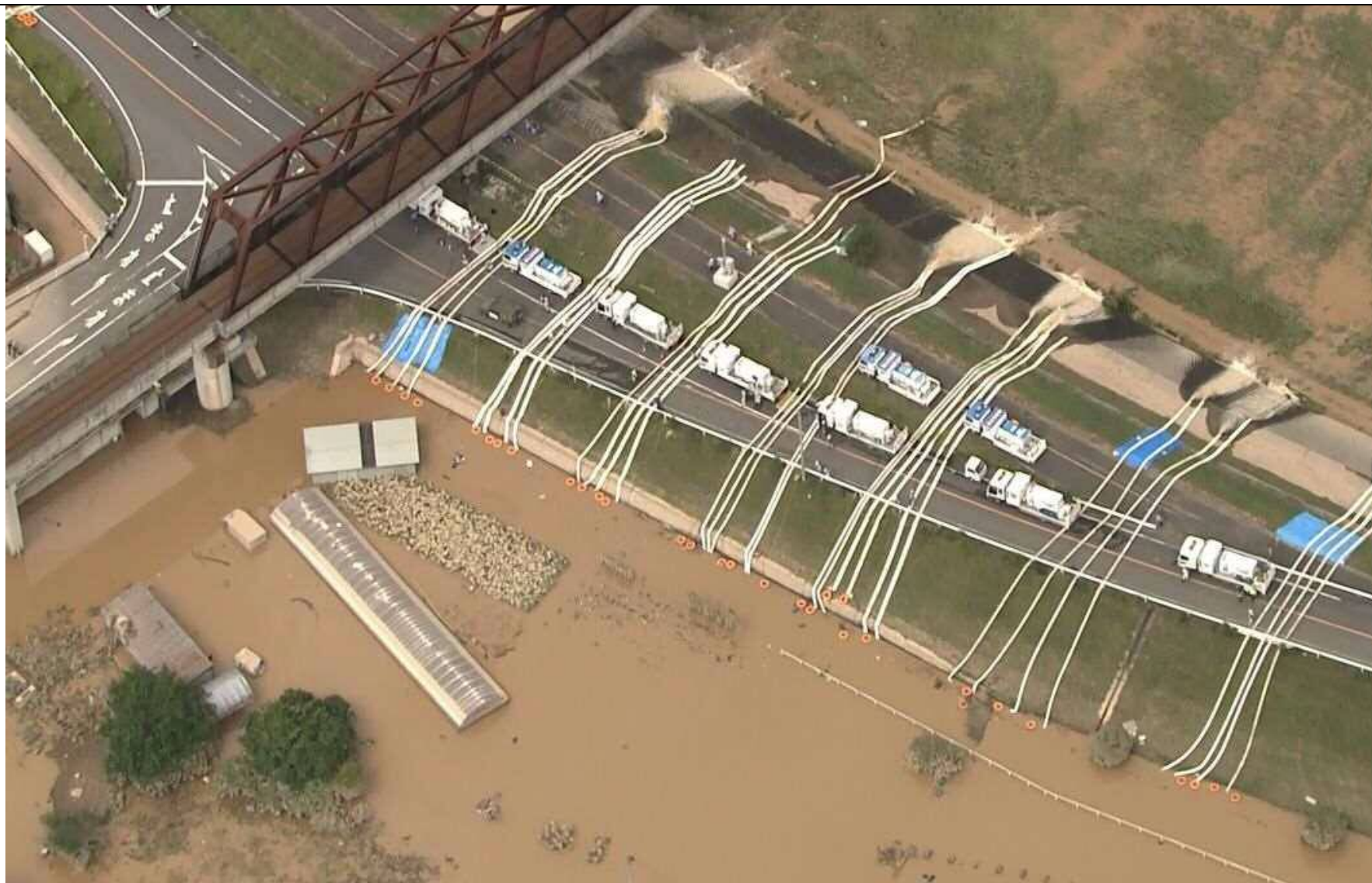
排水ポンプ車による緊急排水（岡山県倉敷市）
