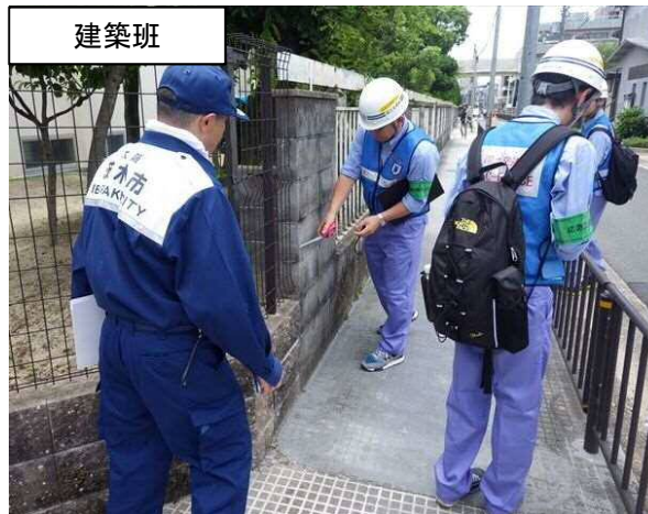
応急危険度判定の調査
