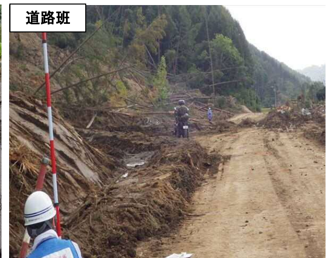
道路の被災状況調査
