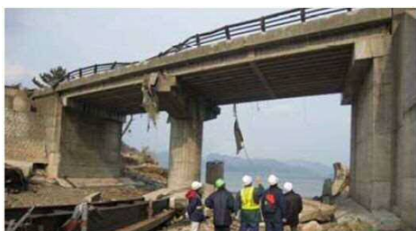
自治体が行う橋梁被害状況調査の支援
