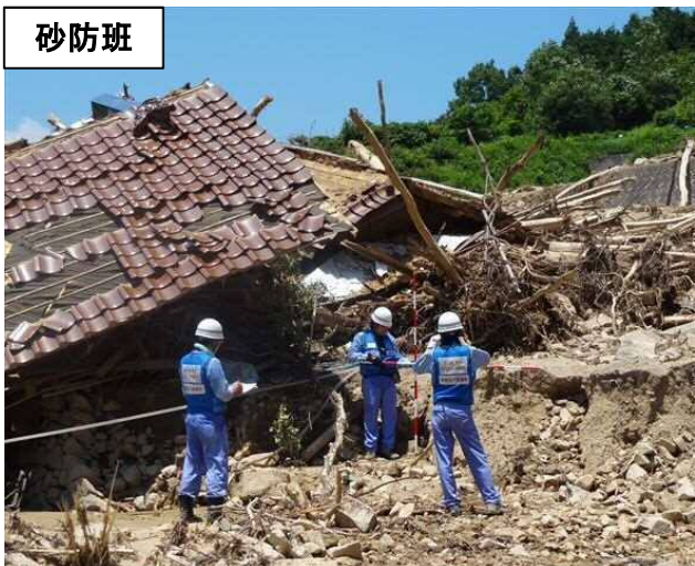
被災状況調査(広島県呉市)
