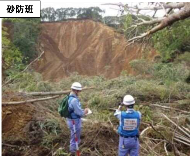
崩落した土砂の堆積状況調査
