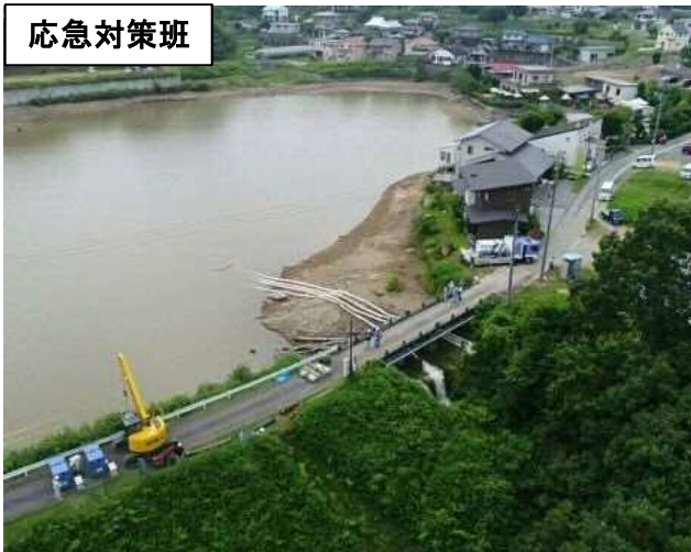
排水ポンプ車による排水作業
