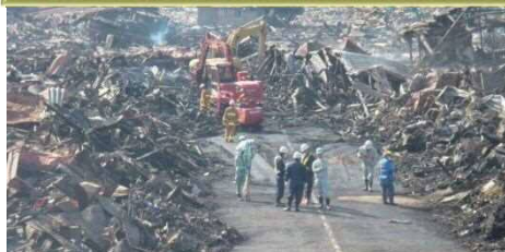
応急復旧に向けた道路啓開の実施
