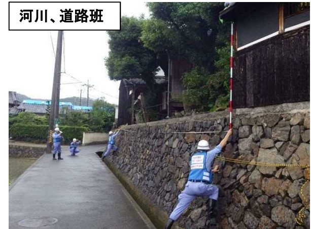
道路の被害状況調査
