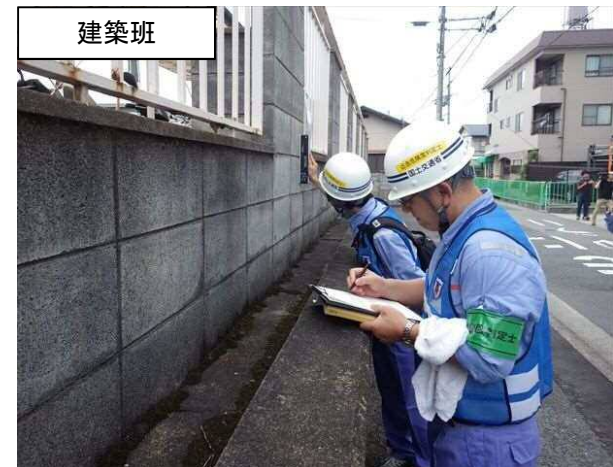
応急危険度判定の調査
