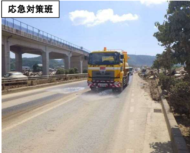
路面清掃状況
