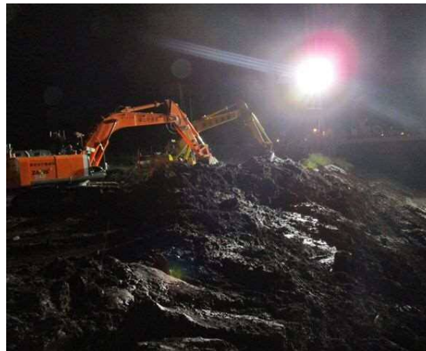
バックホウ（遠隔操縦式）による河道掘削
