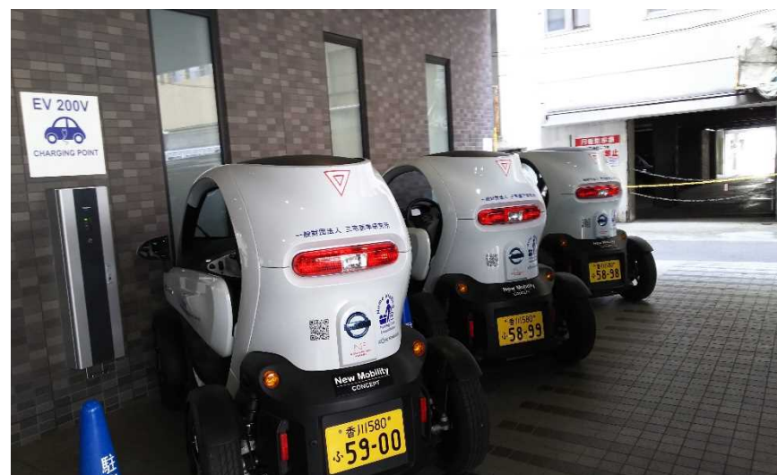
保管場所・充電設備
