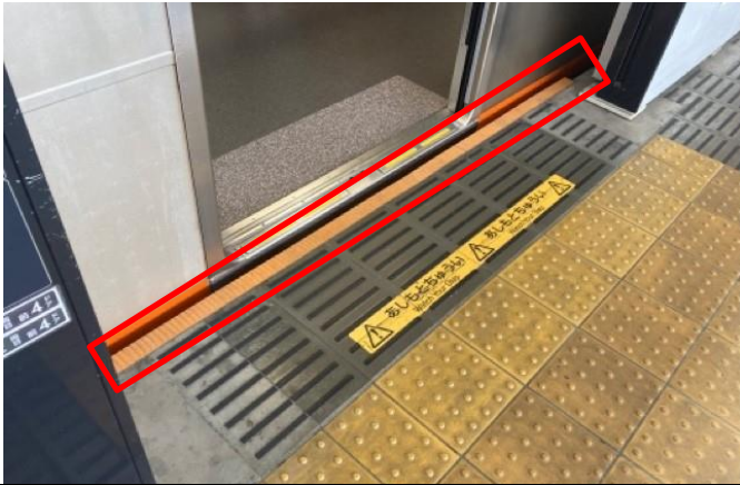
隙間解消工事の実施（大井町駅）
