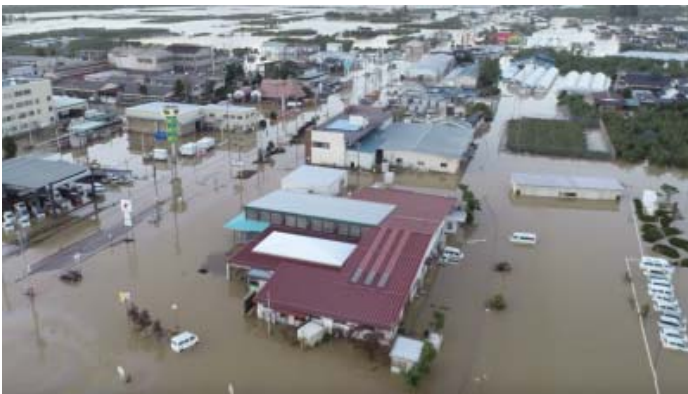
図2-4 長野県長野市大字大町付近の被害箇所
