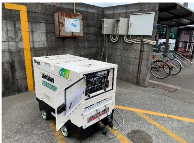
図4-3 バス事業者の電源確保の例
