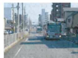
写真2 北九州市のバス専用道路 (市庁舎前。フェンスで区切られていました)
