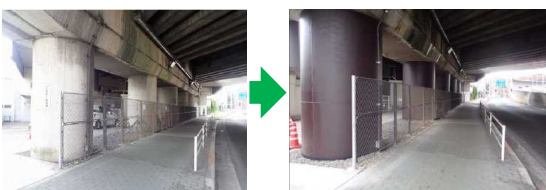
高架橋の耐震補強（鋼板巻き）
