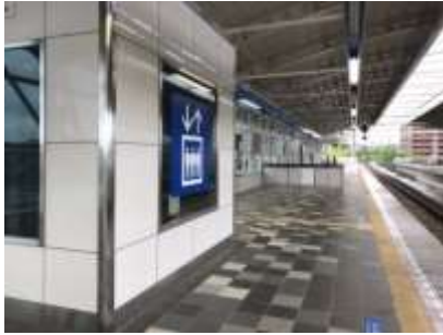
エレベーター設置 (京成おゆみ野駅)
