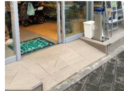
スロープの設置
