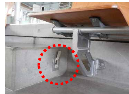
集団補聴設備の設置
