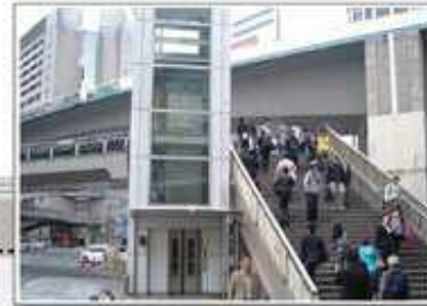
渋谷駅東口歩道橋のエレベーター
