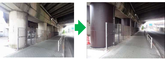
高架橋の耐震補強（鋼板巻き）
