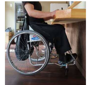
ローカウンターの設置
