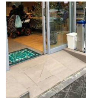
スロープの設置
