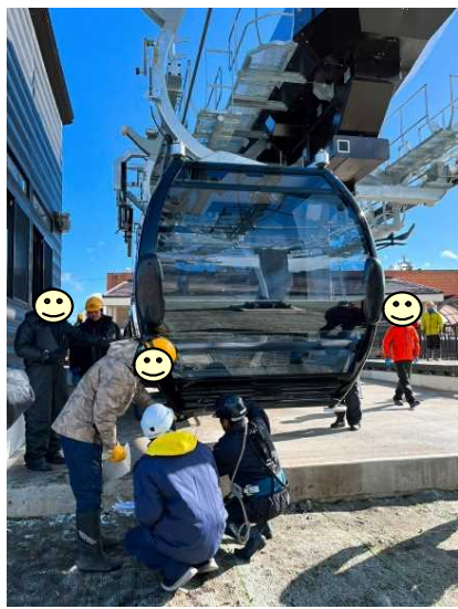
ゴンドラ下面と 停留場の離隔の確認
