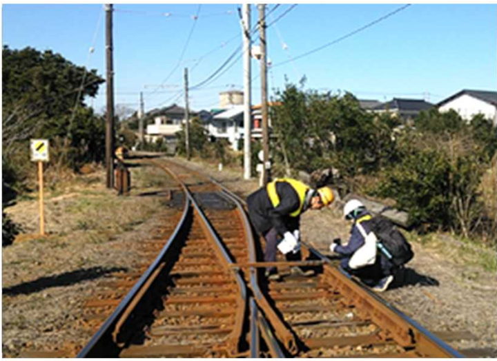
線路のゆがみ等の測定確認
