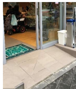
スロープの設置
