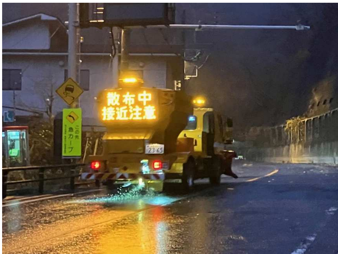
国道17号三国峠 凍結防止剤散布状況 (令和6年11月7日)
