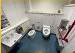
子育てに資する バリアフリートイレの整備
