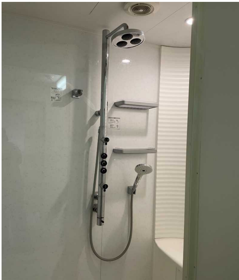
シャワールームの改築（工場）
