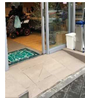
スロープの設置
