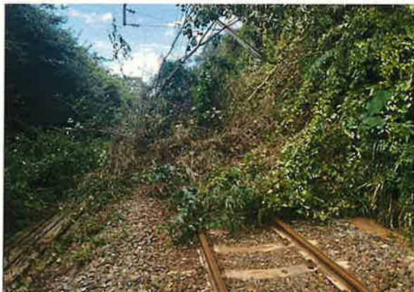
⑥内房線 大貫～佐貫町駅間 土砂流入
