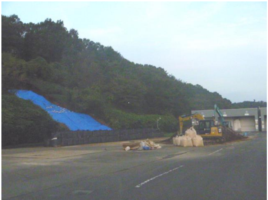
〈応急措置工事の状況〉
