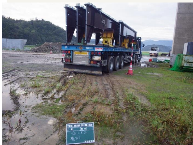
トレーラーの積載状況
