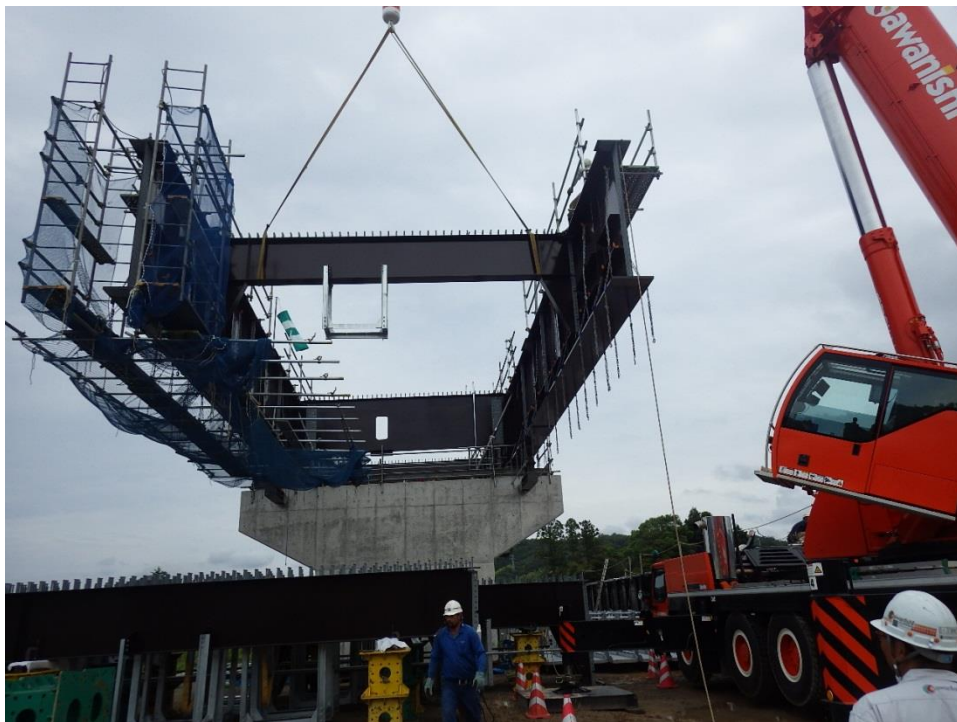
橋梁部材を使った工事状況①
