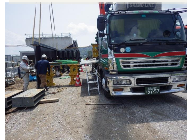
クレーンによる取卸し作業
