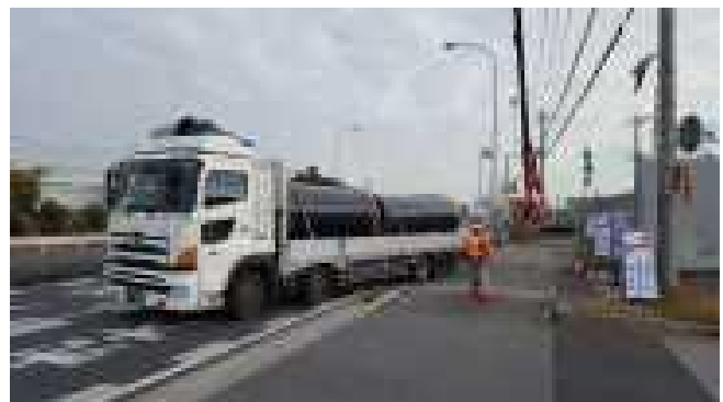
工事現場への納入時の状況
