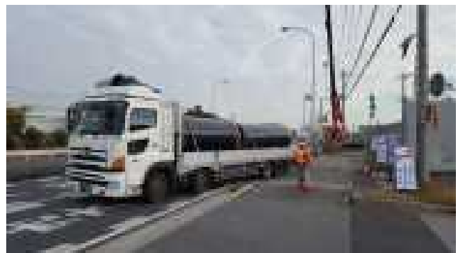
工事現場への納入時の状況
