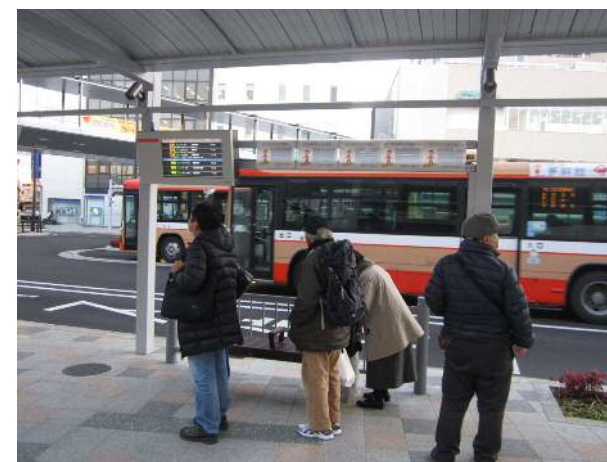
上屋吊下げタイプ のりば ①②③⑦⑨⑩ に整備
