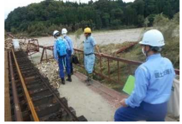
TEC-FORCEによる被災鉄道の現地調査
