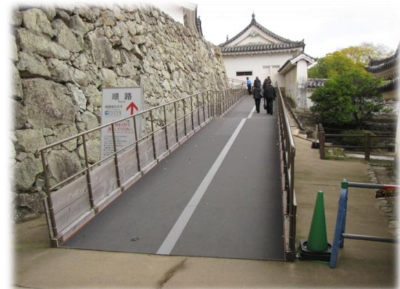
新設のスロープ
