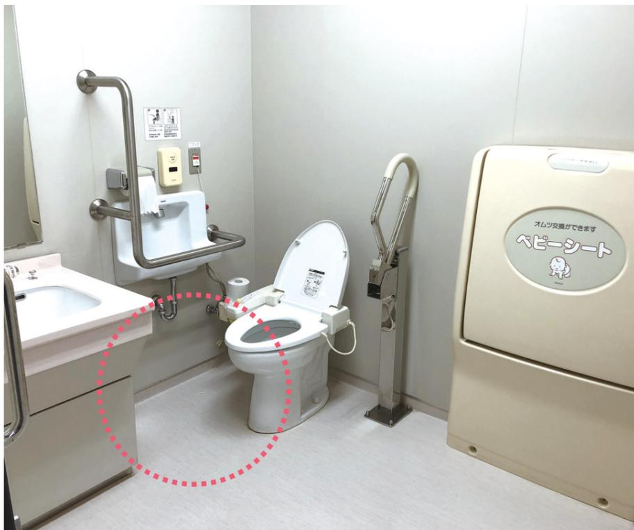
■洗面台が突出していることで、便器前に車椅子の移乗スペースがなくなっている。他にもゴミ箱を置いていることやバリアフリートイレに設備（機能）を詰め込みすぎることによる移乗スペースが確保できていない事例もある。
