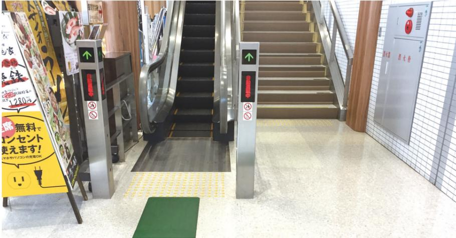
誘導用ブロック(誘導用マット)が階段には敷設されずにエスカレーターの上に敷設
