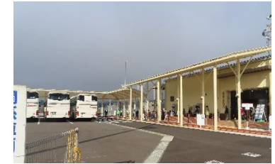
受入環境改善に向けた施設整備状況 (屋根付通路の整備)
