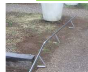
柵が固定されていないため一部 通路を逸脱している箇所あり。
