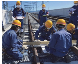
保安監査で軌道の状態を確認
