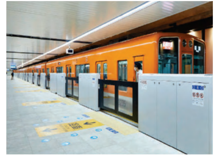
可動式ホーム柵の整備
