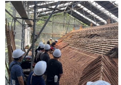
金剛輪寺二天門の葺き替え工事（見学イメージ）
