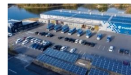
本社工場屋根に 自家消費型太陽光設備を設置
