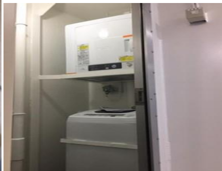
洗濯機と乾燥機
