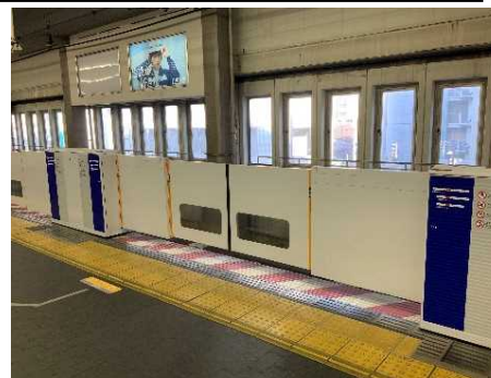
ホームドアの設置
