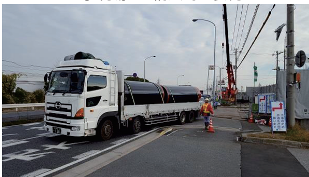
工事現場への納入時の状況
