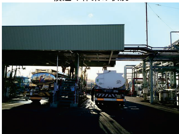
積込み作業の状況
