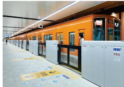
可動式ホーム柵の整備
