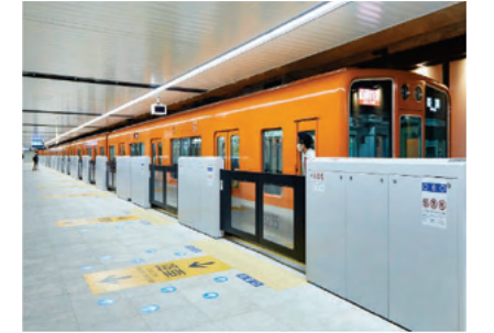
可動式ホーム柵の整備
