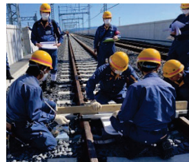
保安監査で 軌道の状態を確認
