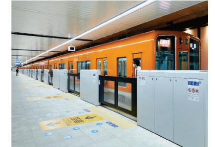
可動式ホーム柵の整備
