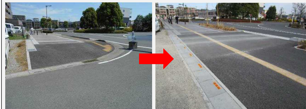
視覚障害者誘導用ブロックの改修、グレーチングを目の細かいものに改修
