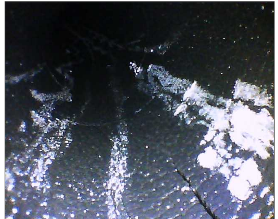
(図.3) 6年間使用したエアチャージホースの内部 資料提供：兵庫県警
