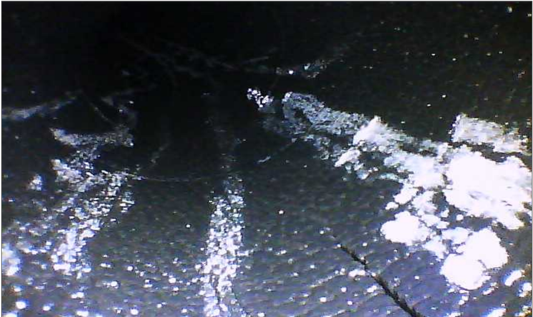
(図.3)6年間使用したエアチャージホースの内部
