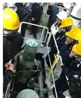
消防ポンプの作動状態を 見る生徒たち
