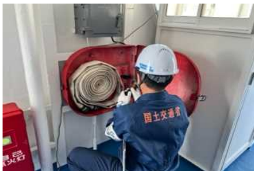
消火ホースの点検
