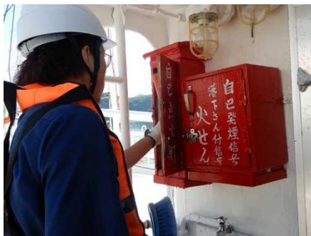
<救命設備の点検風景>
