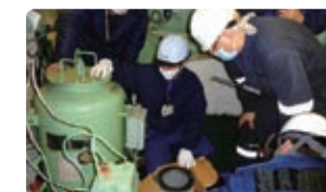
機関室の油水分離器の検査
