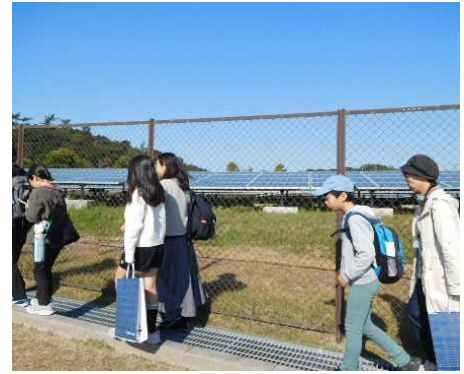
くにうみ太陽光発電所
