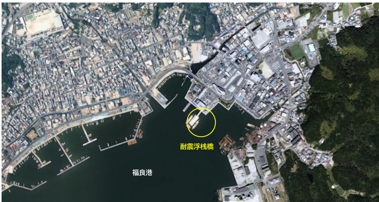
図 福良港の耐震浮棧橋
