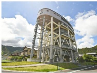
佐賀地区津波避難タワー見学
