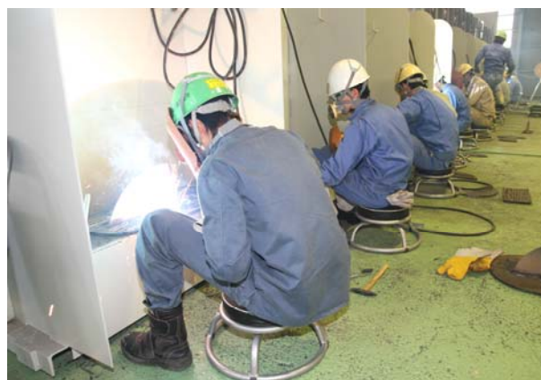
溶接作業の研修
