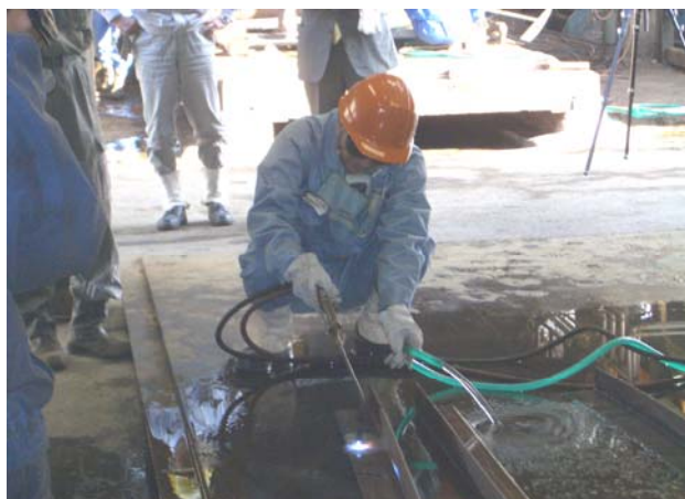
ぎょう鉄作業の研修
