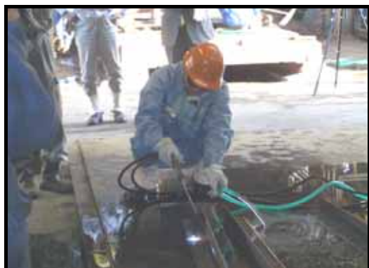
ぎょう鉄作業の研修
